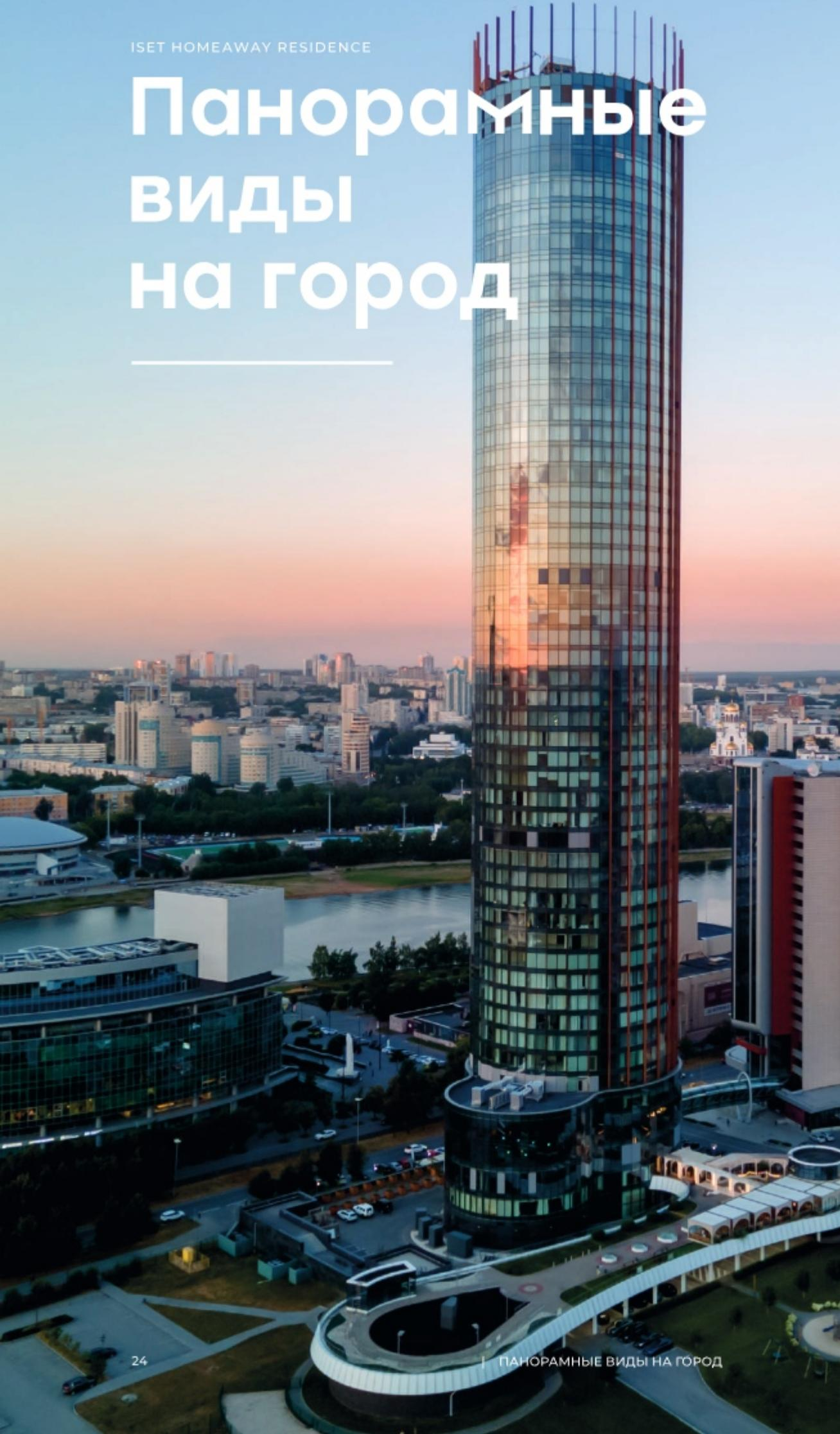
Снаружи здание ISET TOWER закрыто стеклопакетами двух фасадных конструкций. Панорамное остекление фасада выполнено из специального стекла с серебряным напылением.
